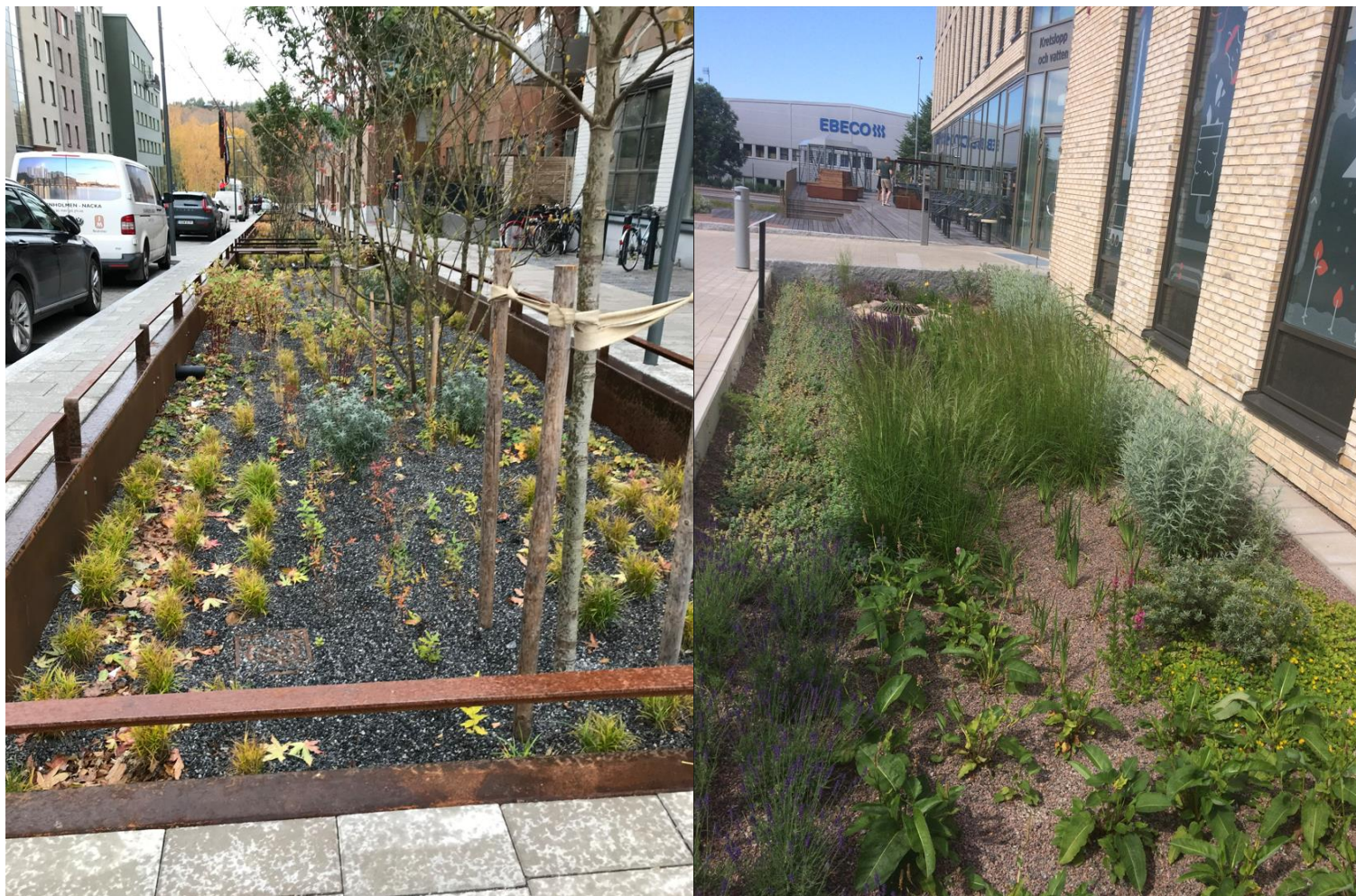
Figur 11: till vänster: Nedsänkta biofilter, Settegatan Stockholm, fotograf: Sofia Augustsson, till höger: Nedsänkta biofilter, Alelyckan GBG, fotograf: Linnéa Lundberg.
